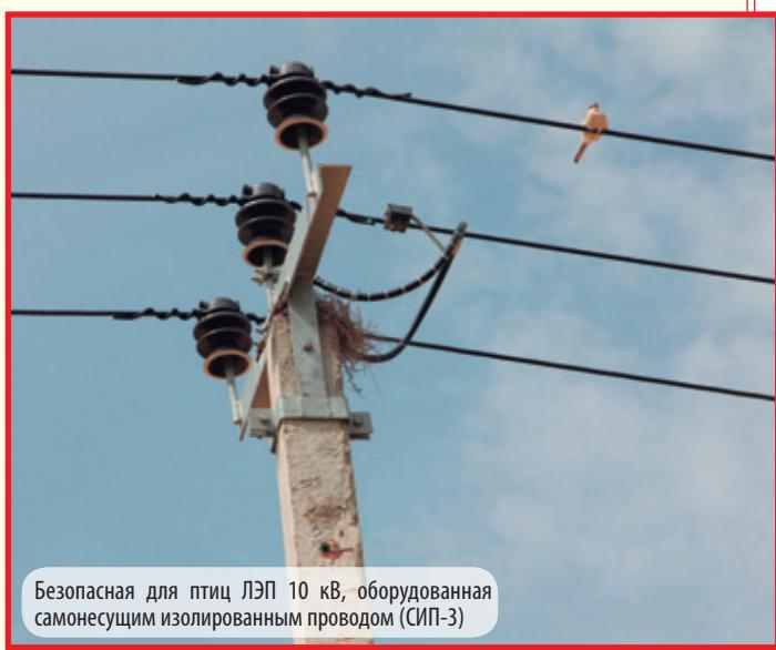
Безопасная для птиц ЛЭП 10 кВ, оборудованная самонесущим изолированным проводом (СИП-3)
