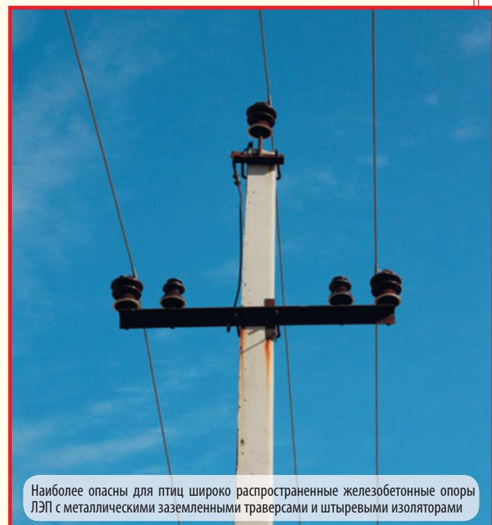
Наиболее опасны для птиц широко распространенные железобетонные опоры ЛЭП с металлическими заземленными траверсами и штыревыми изоляторами
