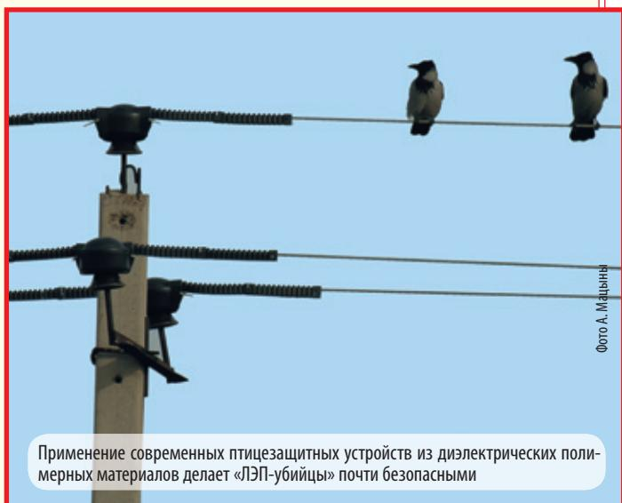
Применение современных птицезащитных устройств из диэлектрических полимерных материалов делает «ЛЭП-убийцы» почти безопасными
