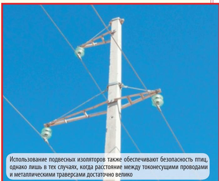
Использование подвесных изоляторов также обеспечивает безопасность птиц, однако лишь в тех случаях, когда расстояние между токонесущими проводами и металлическими траверсами достаточно велико
