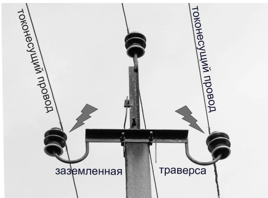
Рисунок 2. Небольшое расстояние между токонесущими и заземленными элементами в районе оголовка опоры ВЛ 6-10 кВ определяет высокую опасность конструкции для объектов животного мира.
