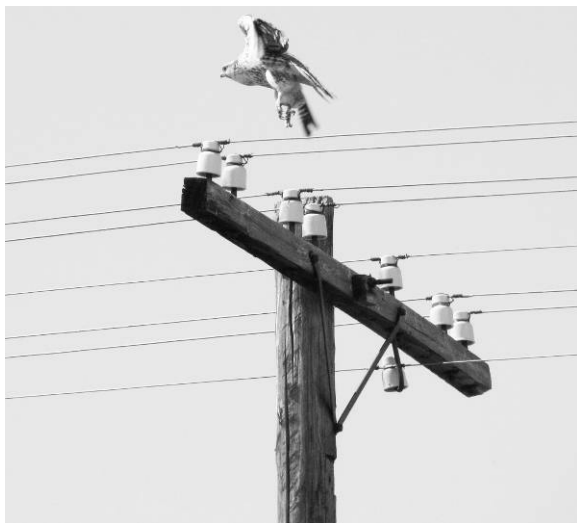
Рисунок 10. Деревянная опора воздушной линии связи.
