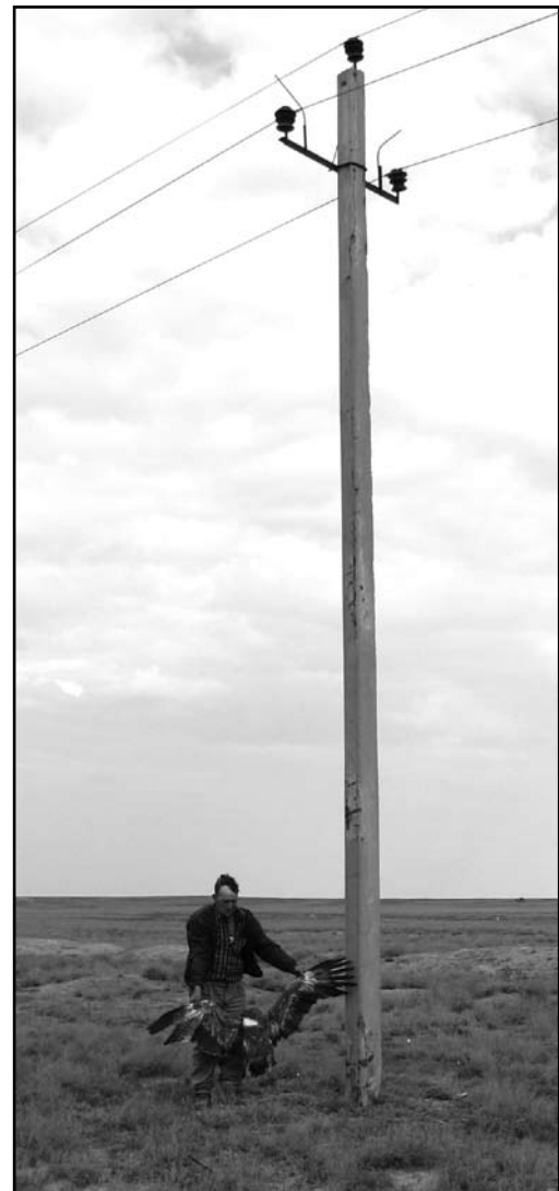
Опора ВЛ катодной защиты АО «КазТрансГаз» с отпугивающими птиц устройствами в виде «усов», запрещёнными ещё в СССР. Подобные ВЛ до сих пор строятся в Казахстане и убивают множество птиц. Степной орёл, погибший под этой опорой 26 апреля 2010 г. Фото Ф. Сараева.
